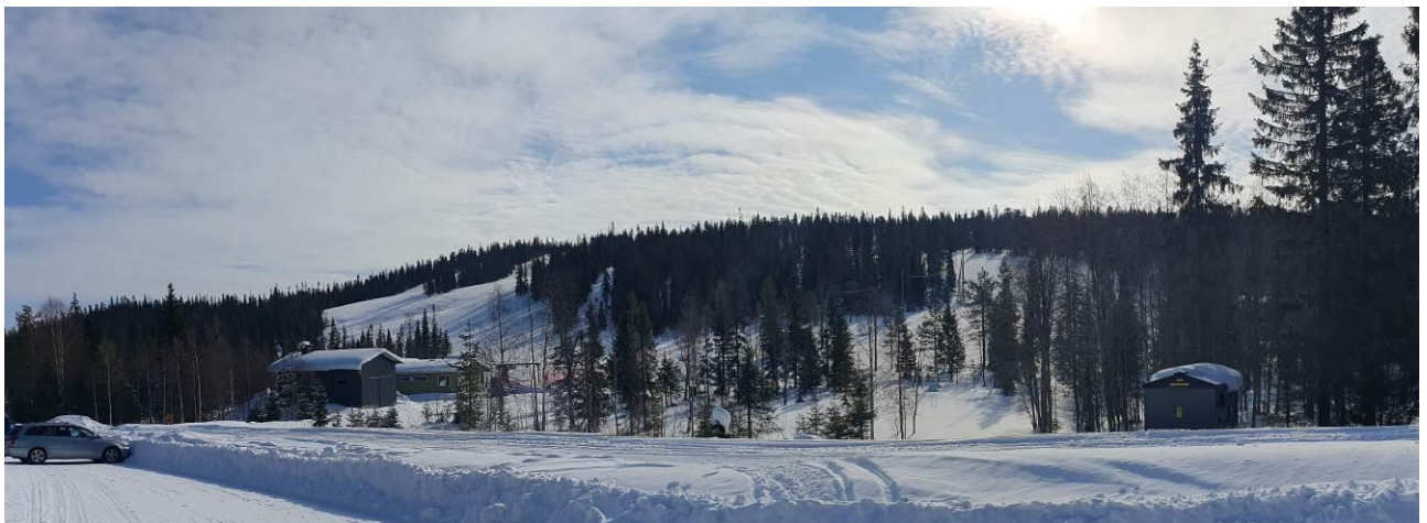
Kuva 8 Kirintövaaran rinnealueita ja huoltorakennuksia
