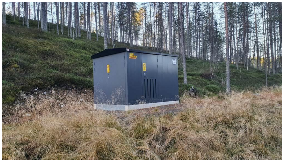
Kuva 13 Puistomuuntaja alueen sisääntulotien varrella (Kuva: Kimmo Mustonen 20.10.2022)
